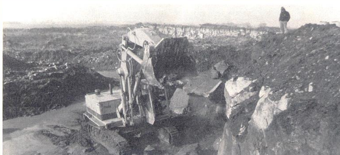
Disgaggio dei massi dal banco.
