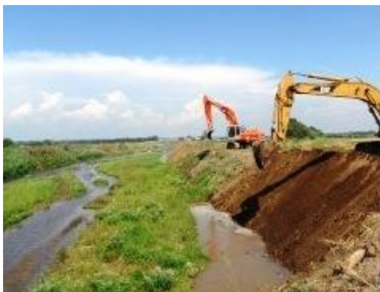
Allargamento sezione di deflusso (Enlargement section outflow)
