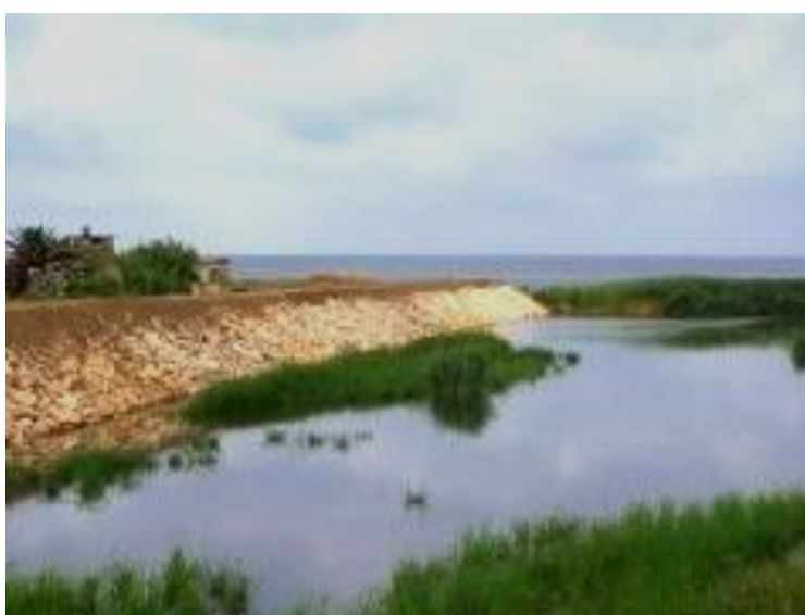
Rilevato arginale e scogliera spondale di protezione (Detected embankment and cliff riverbank protection)
